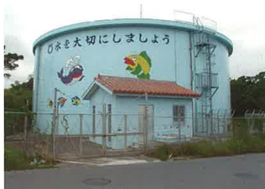
住宅地にあり景観に配慮しました。手前が緊急遮断弁室。
