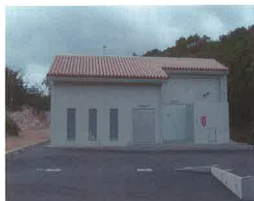
八重瀬配水池へ2基のポンプで送水。
