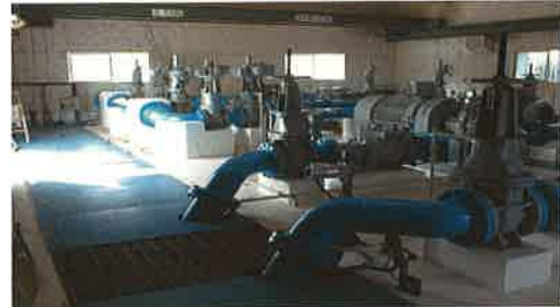
5基のポンプで毎日およそ18,000m 3 の水を送水しています。
