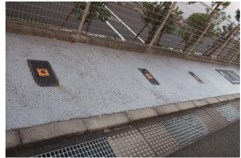
臨時トイレ対応マンホール
