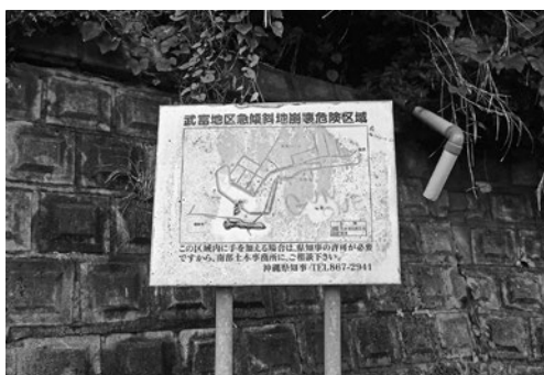
武富地区急傾斜地の工事が開始される
