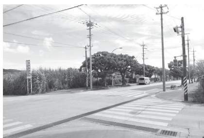
長い間改善の求められている冠水箇所
