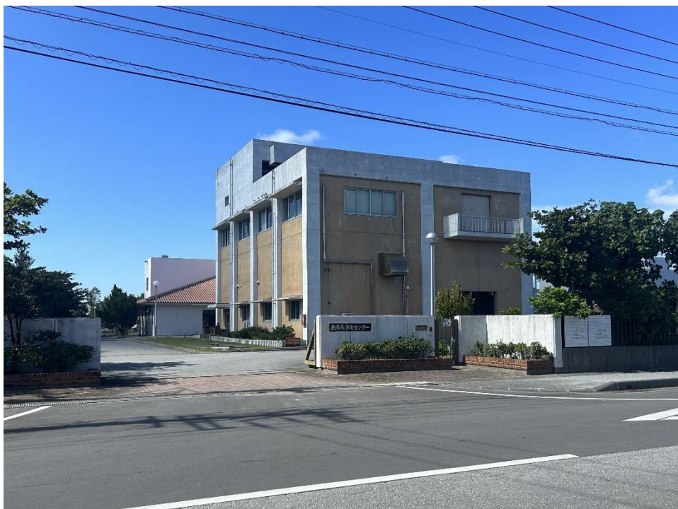
写真 3-2 糸満市浄化センター終末処理場の外観
