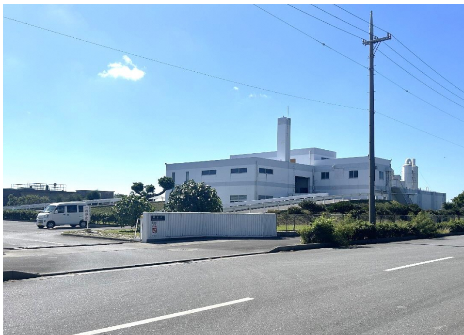
写真 3-1 岡波苑し尿処理施設の外観
