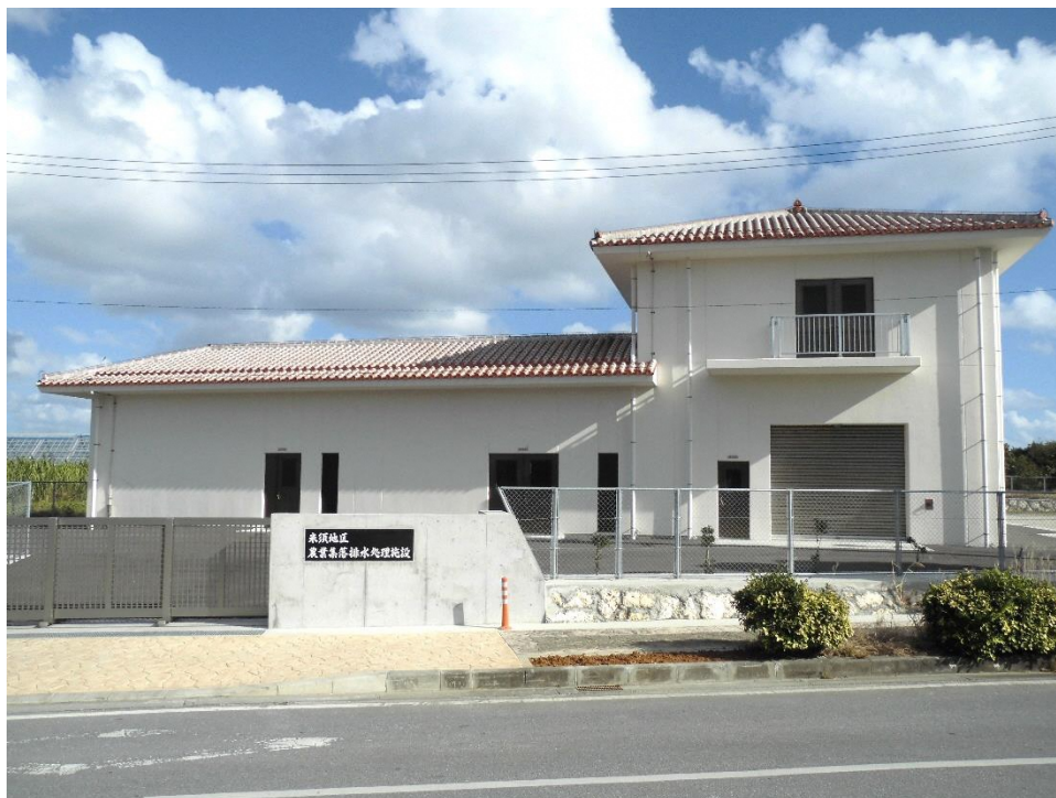
写真 3-3 農業集落排水処理施設の外観
