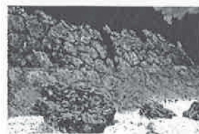
台風の高波による浸食、 土壌の流失
