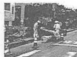
上水道本管の耐震管への更新
