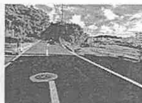
市道浜川線・兼城ハイヴ線 アスファルト修繕舗装
