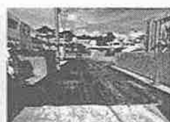
マーツ小広場 アスファルト張替え舗装
