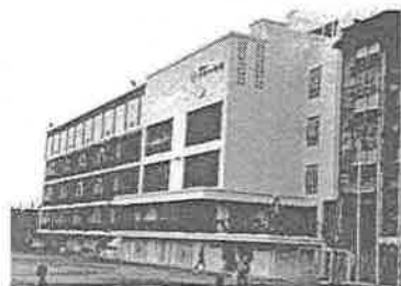
兼城小学校校舎の改築(プール併設)完成
