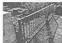
潮平地内通学路段差部の手すり設置
