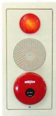
ボタンを押すことで火災発生を知らせる信号を送るとともに音響装置を作動させます。
