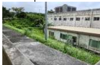
社会福祉センター裏側道路
