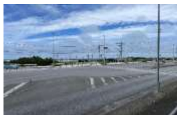
旧南部病院入口付近国道
