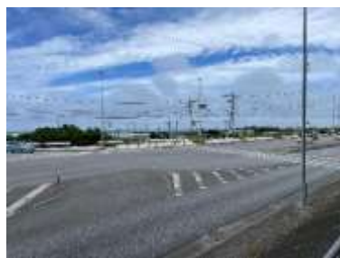
旧南部病院入口付近国道
