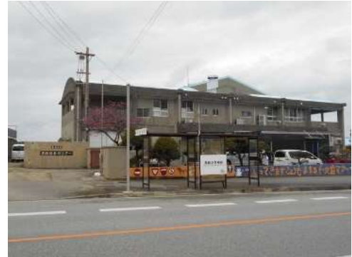
■既存の給食センター
