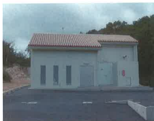
八重瀬配水池へ2基のポンプで送水。
