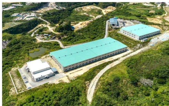
美らグリーン南城 （最終処分場）
