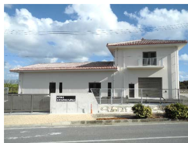
米須地区農業集落排水処理施設
