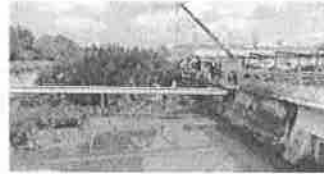
マングローブ撤去
