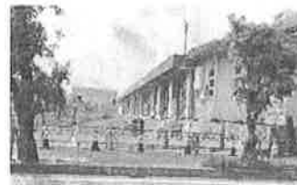
乗入れ口整備中
