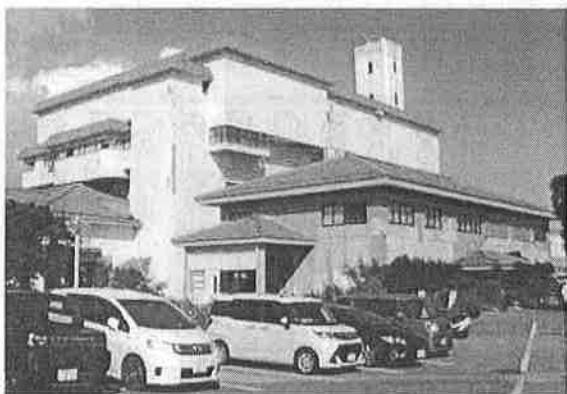
老朽化している糸豊環境美化センターは延命化に向け基幹改良工事が必要
