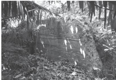
与座の上座原地内の丘陵頂上部の雑木林の中、拝所ウィーザトゥンの奥にトーチカ跡がある。太い鉄筋を何本も配列したコンクリート製のトーチカの内側は、縦約2.7m、横4m、高さ1.5m。現在、天井部分はない。トーチカの東側10m程先には陣地壕の出入口がある。壕の内側は途中で落盤している。壕とトーチカの間にはこの2つを繋ぐ溝が掘られている。
