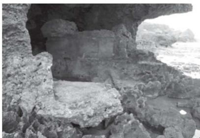
喜屋武の南端の断崖上に形成された具志川城跡の真下。太平洋を臨むように海岸の岩穴にコンクリート製トーチカが構築されている。米軍の上陸に備え築かれた陣地と考えられる。潮風と波にさらされながら、側壁部分と床面の一部が、岸壁にへばり付くように辛うじて残っている。
