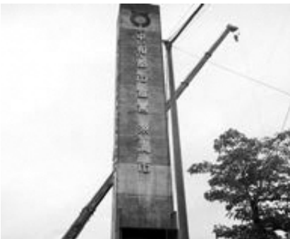
西崎運動公園給水塔
