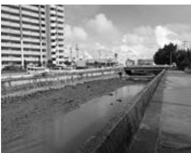
ニュータウン東側の河川護岸
