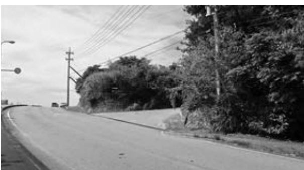
県道との取付箇所
