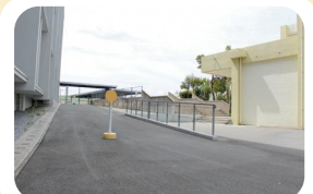
体育館前スロープ
