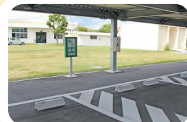
屋根付き駐車場
