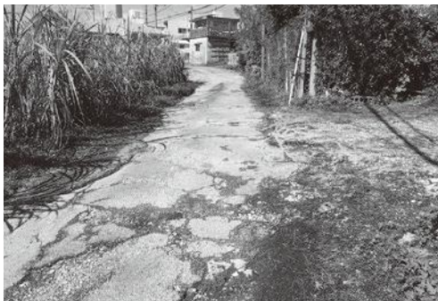
凹凸が見られる当該道路（阿波根橋口線）
