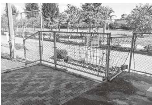
西川町公民館のフェンス
