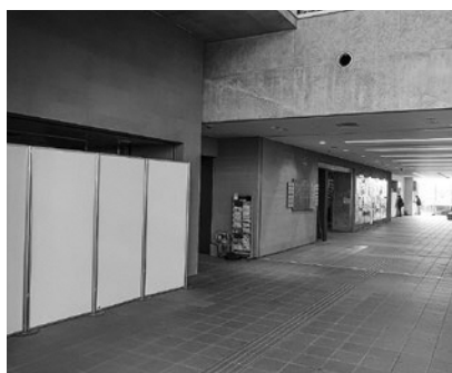
庁舎内1階のコンビニ跡
