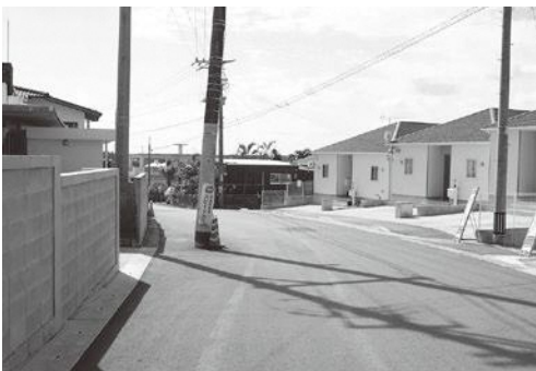
取り残された電柱の早期撤去が求められる
