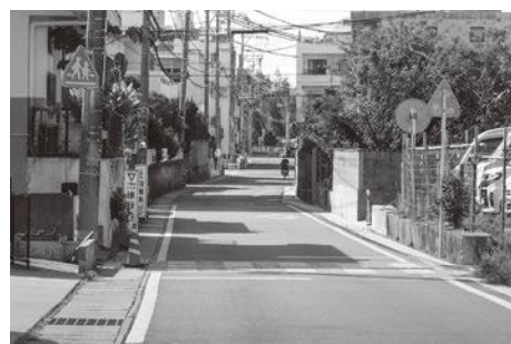
雨水対策工事完成箇所（道路下にボックスカルバート排水路埋設）
