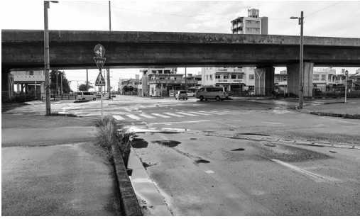
今年度ラウンドアバウト工事が着手予定の交差点 (糸満豊見城バイパス高架下)
