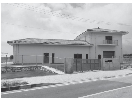
農業集落排水処理施設
