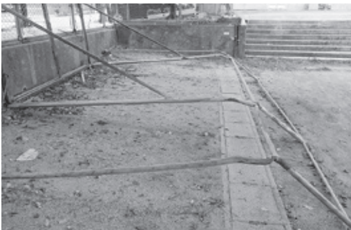
台風で倒れた糸満小学校運動場のバックネット
