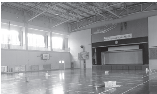
小中学校体育館の雨漏り対策を (潮平小学校体育館)
