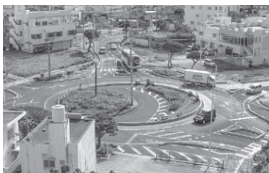
電線地中化を予定している糸満ロータリー周辺
