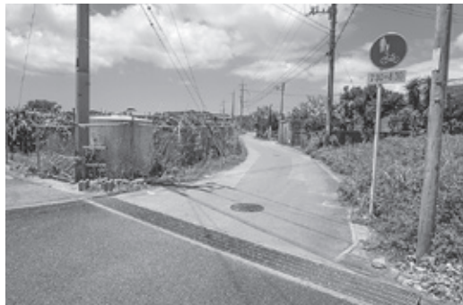
歩道整備が必要な市道米須大度線
