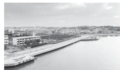
(仮称) 文化・平和・観光振興センター建設予定地
