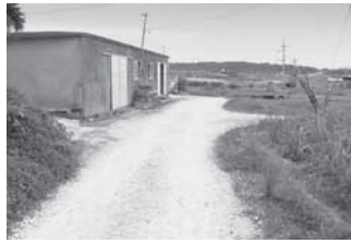
舗装工事が予定されている 小波蔵367番地の1付近
