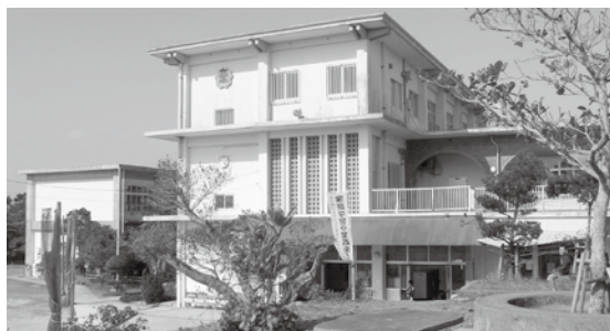
老朽化への対応が求められている (高嶺小学校校舎)
