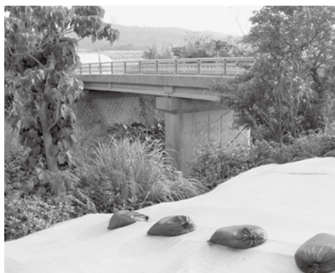
復旧工事が行われている 与那嶺原橋付近
