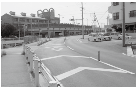
工事が終了した潮平小学校交差点付近
