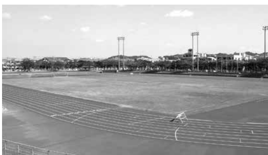
12月に改修工事予定の陸上競技場の芝部分
