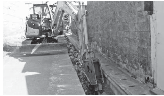
水道工事の様子（配水管布設）
