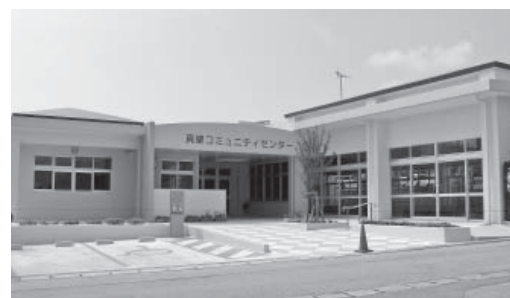
平成26年4月1日より供用開始された 真壁コミュニティセンター
