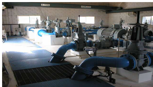
5基のポンプで毎日およそ18,000m 3 の水を送水しています。
