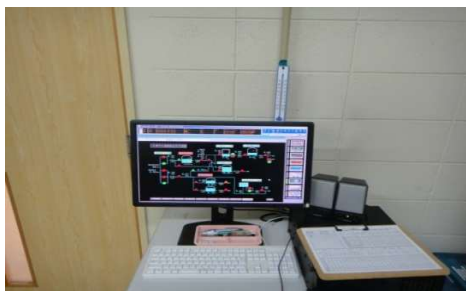
中央監視制御システム(計装設備)
