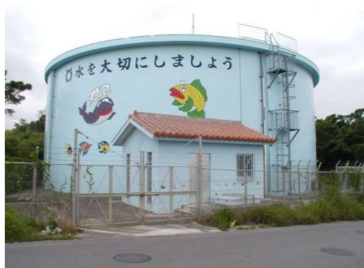
住宅地にあり景観に配慮しました。手前が緊急遮断弁室。
