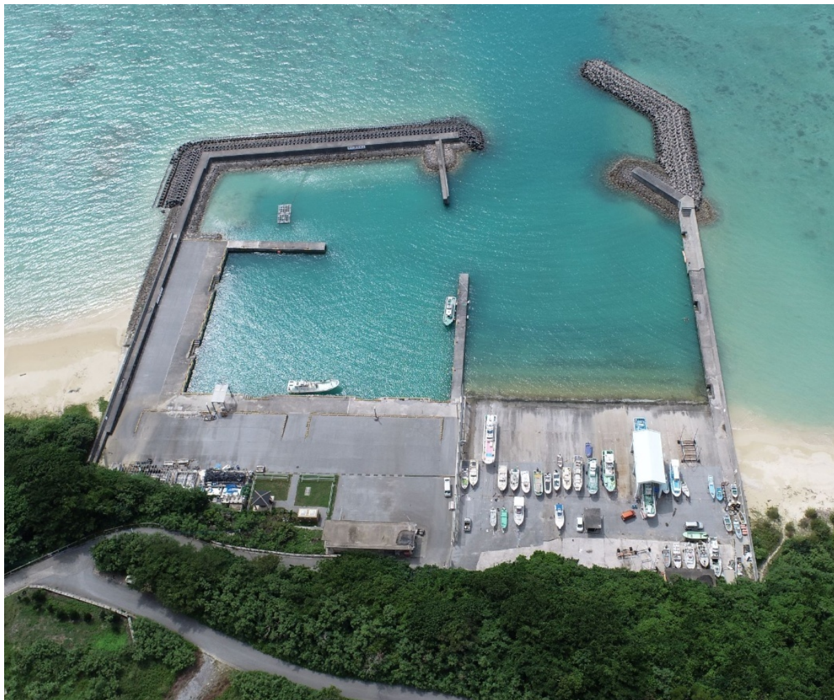
図 4-14 喜屋武漁港全景 13
