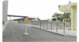
体育館前スロープ
