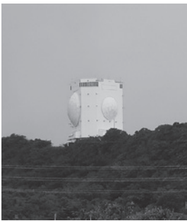
与座岳に設置されている カメラレーダー
