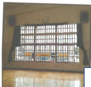
糸満がじゅまる児童センターカーテン取替工事
