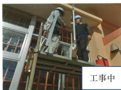
糸満がじゅまる児童センター戸車取替工事
