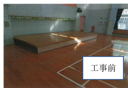
西崎太陽児童センター機能強化工事
