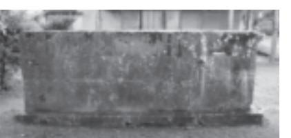
喜屋武の民家に残るヒンブン。ヒンブンとは門と母屋との間に設けられた目隠しのことである。戦前この屋敷には瓦葺きの家屋があったが、沖縄戦で破壊され、このヒンブンと屋敷を囲む石垣だけが残った。8枚の琉球石灰岩からなるヒンブンには、砲弾が貫通してできた縦約10cm、横30cmの穴が残る。
