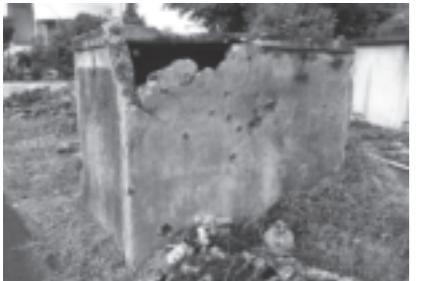
字名城42番地に残る高さ約1.7m・横1.6m・幅2.2mの方形のコンクリート製の水タンク。戦前、ここには屋号「仲海勢頭」の瓦葺きの家があり、家には老夫婦が暮らしていたが、沖縄戦で二人とも地元で亡くなる。家屋も破壊され、四方に弾痕のある水タンクだけが残った。
