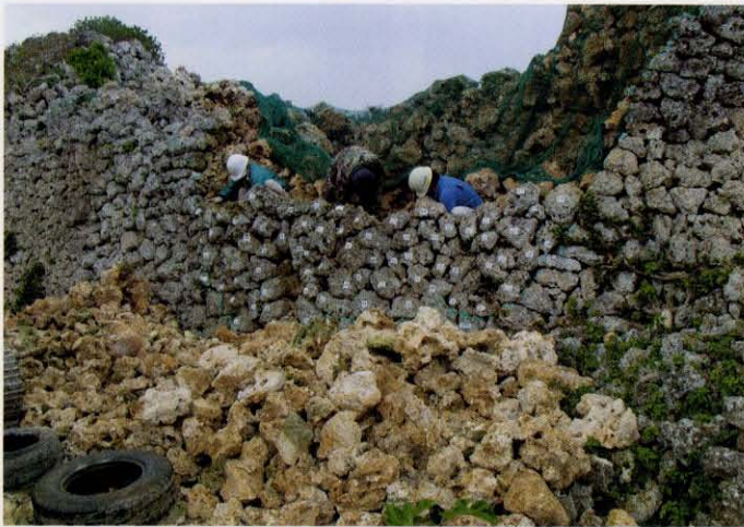
北のアザナ、石垣解体風景。
