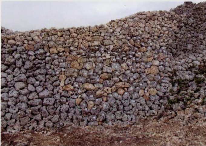
解体後、新たに積み上げられた石垣。
