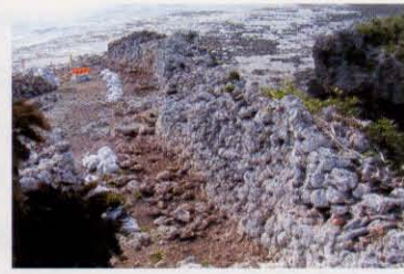
基礎部が現れた西側石垣
