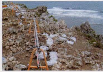
確認された岬先端石垣基礎
