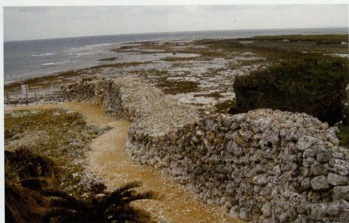
Fig2 修復された岬の郭西側石垣
