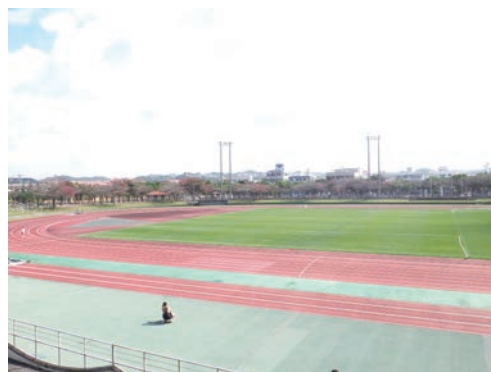
西崎運動公園陸上競技場
