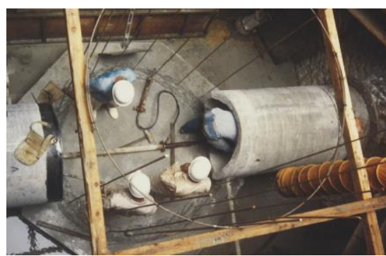
<昭和 60 年 中央幹線汚水工事>
