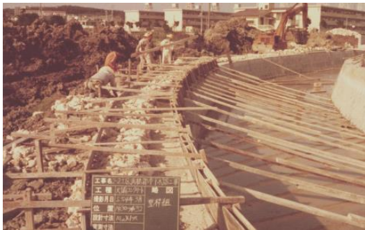
<昭和 53 年 満橋都市下水路工事>
