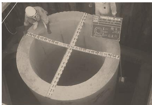
<昭和 60 年 中央幹線人孔築造工事>
