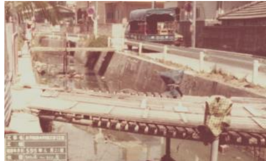
<昭和 55 年 施工前の双子橋雨水路>
