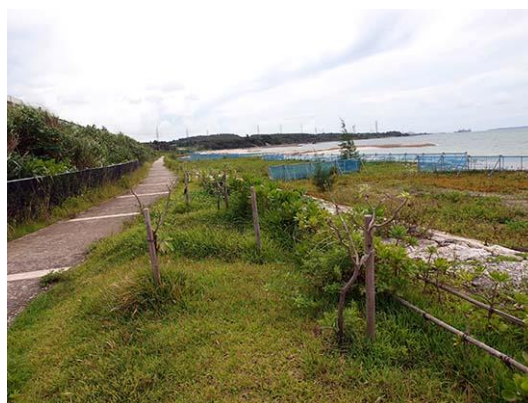
近自然護岸を採用(伊芸海浜公園)
