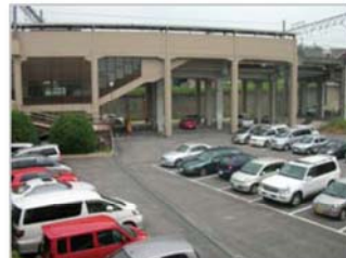
駅に併設した駐車場（三好ヶ丘駅）
