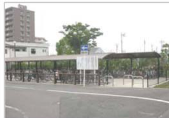
整備された駅前駐輪場（三河豊田駅）
