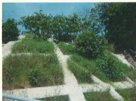
コンクリート法面の枠を植栽枠に利用した緑化
