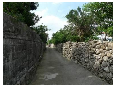
真壁集落内に残された石積み
