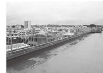
西崎中学校の屋上に設置された安全フェンス
