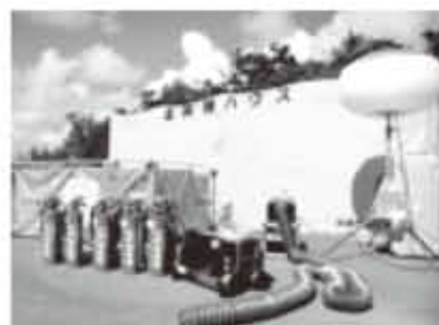
配備された防災機材
