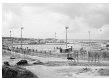
南浜公園多目的広場
