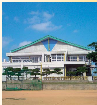
10月 糸満小学校 体育館完成
