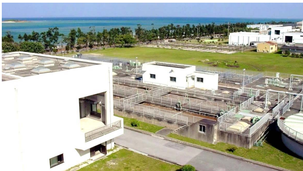
写真 3-2 糸満市浄化センターの外観
