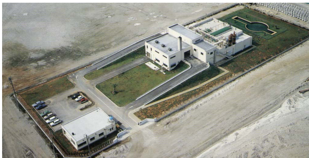
写真 3-1 岡波苑し尿処理施設の外観
