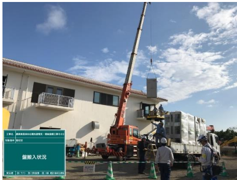
〈米須地区汚水処理施設建設〉
