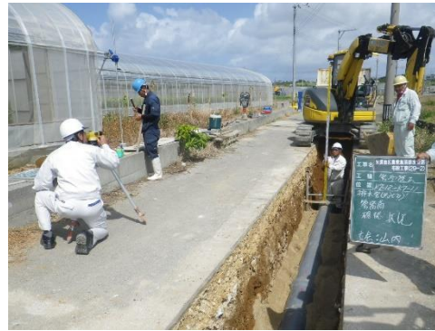
〈米須地区農業集落排水管路布設工事〉
