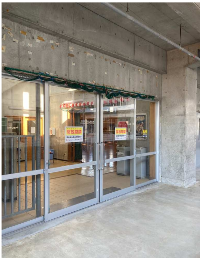
① 体育館正面玄関遠景
