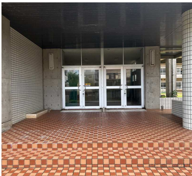
①体育館正面玄関遠景
