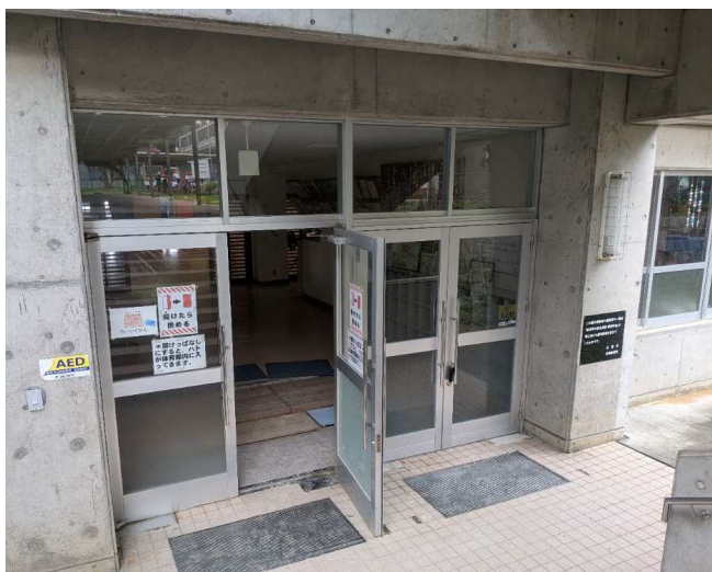
①体育館正面玄関遠景
