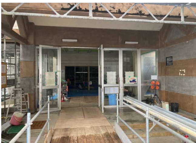
①体育館正面玄関遠景
