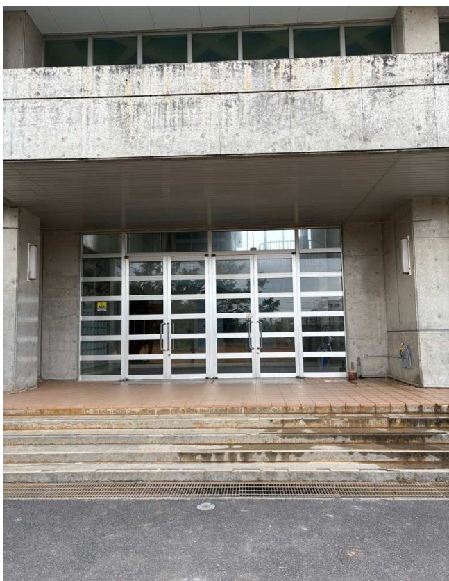
①体育館正面玄関遠景
