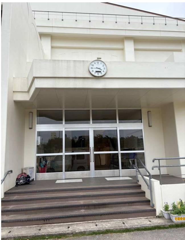
① 体育館正面玄関遠景
