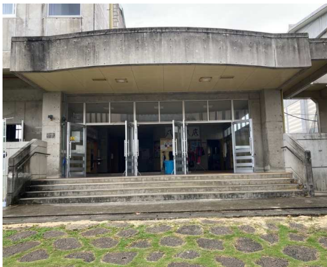
①体育館正面玄関遠景
