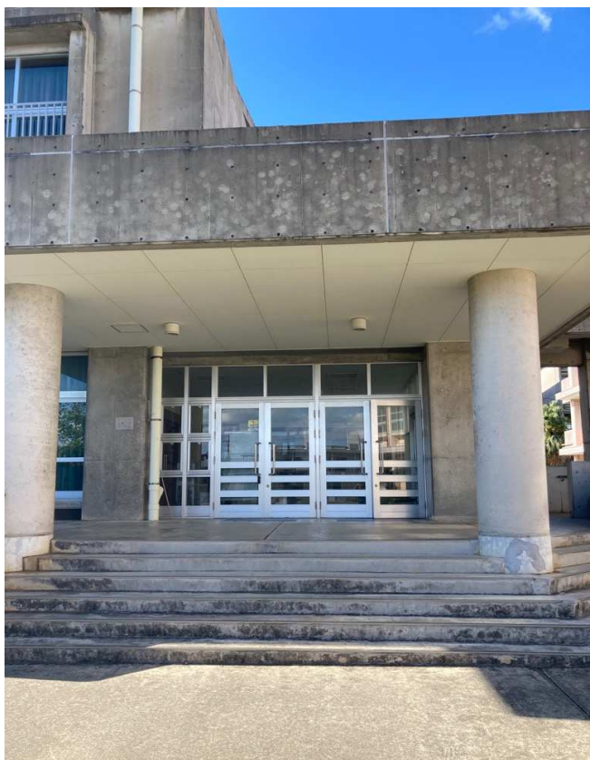
①体育館正面玄関遠景
