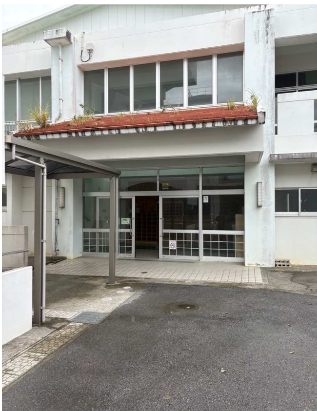
① 体育館正面玄関遠景
