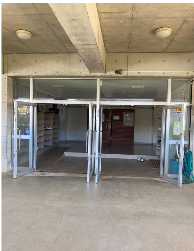
① 体育館正面玄関遠景
