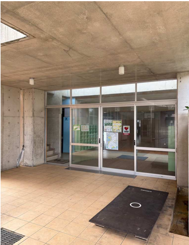
①体育館正面玄関遠景
