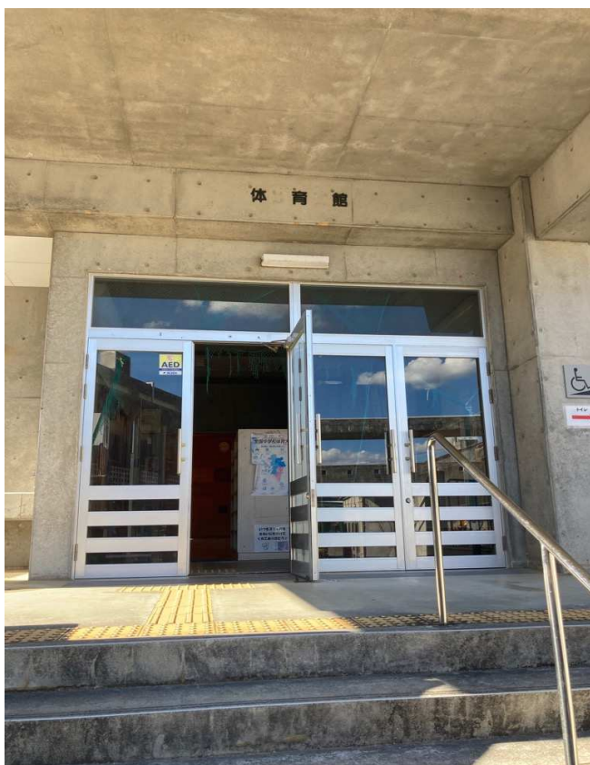
①体育館正面玄関遠景
