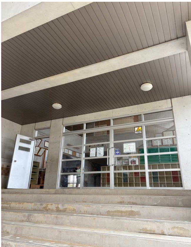
① 体育館正面玄関遠景
